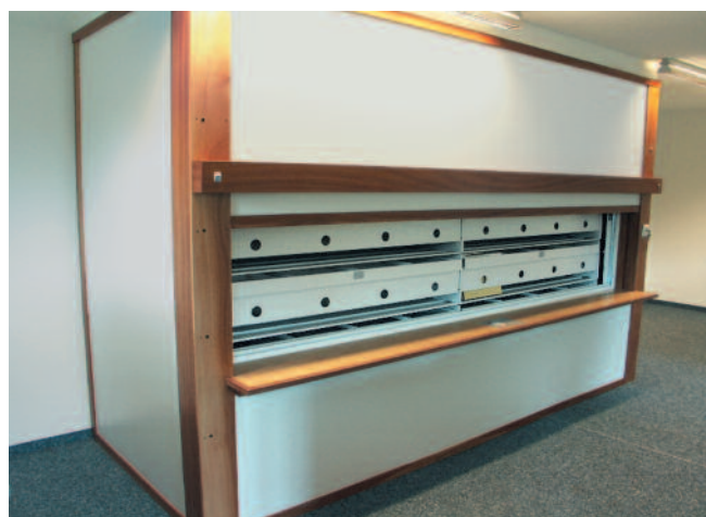
Einkleidung mit Fermacell® F60
